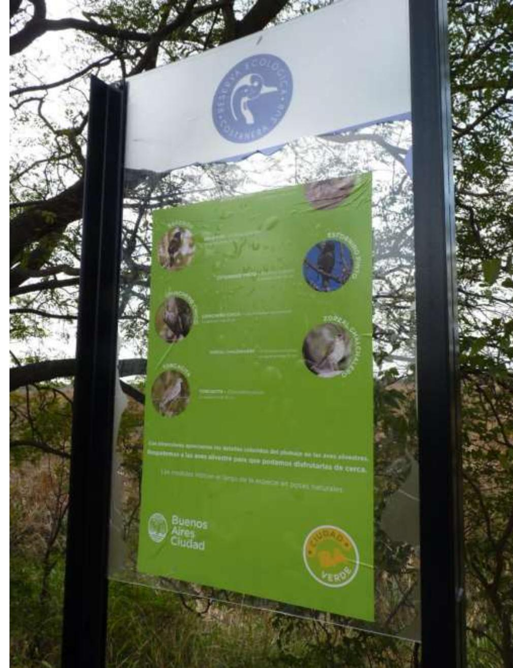
Cada cartel cuenta con una base de hormigón con tratamiento antivandálico, estructura de hierro con pintura antivandálica y lámina de policarbonato transparente donde irá colocado el ploteo.
